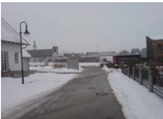
Abb. 6: Hubensteinerstraße, Blick nach Norden (im Hintergrund Plangebiet)
