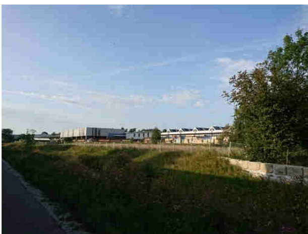
Bild 3: Firmengelände Klöpfer Nordostansicht
