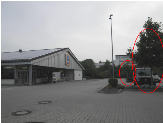
Abb. 8: Blick auf den bestehenden Filialeingang und die zu entfernenden 3 Spitzahorne
