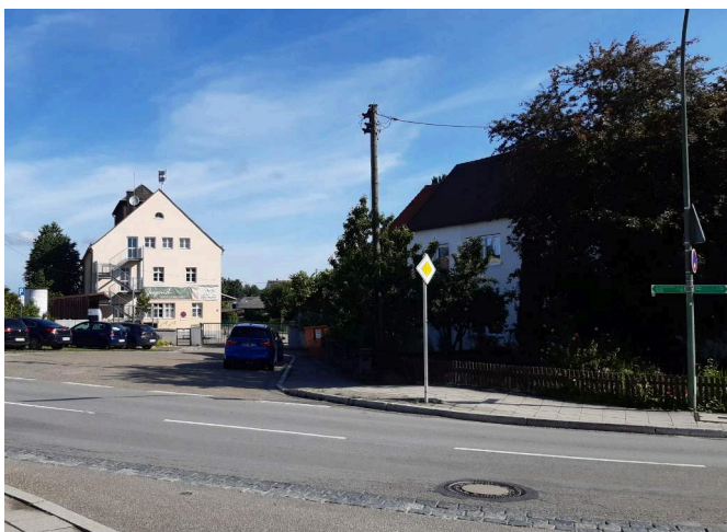
Ausgeschilderter Radweg ohne räumliche Abgrenzung
