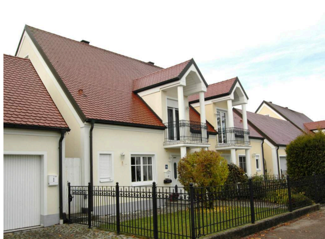
Doppelhäuser in Kapuzinerstraße
