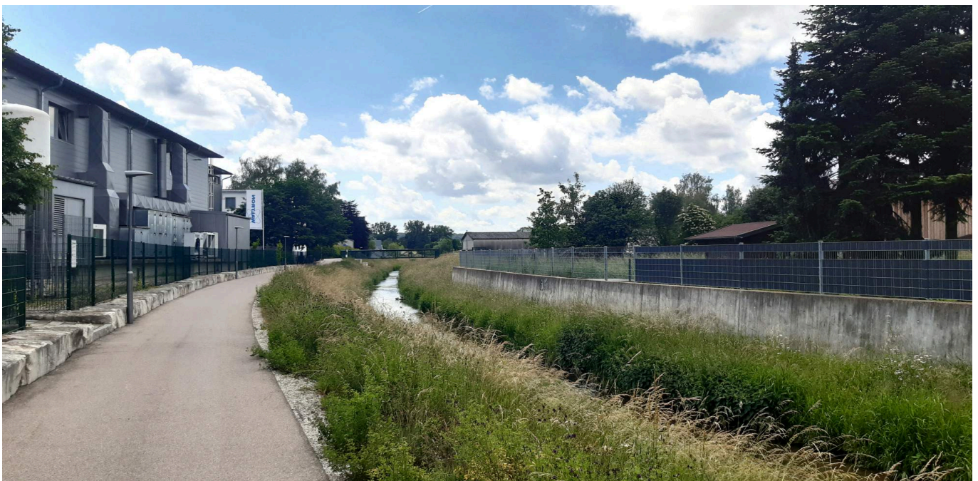
Betonmauern als Hochwasserschutz und Uferbewachung entlang der Wolnzach
